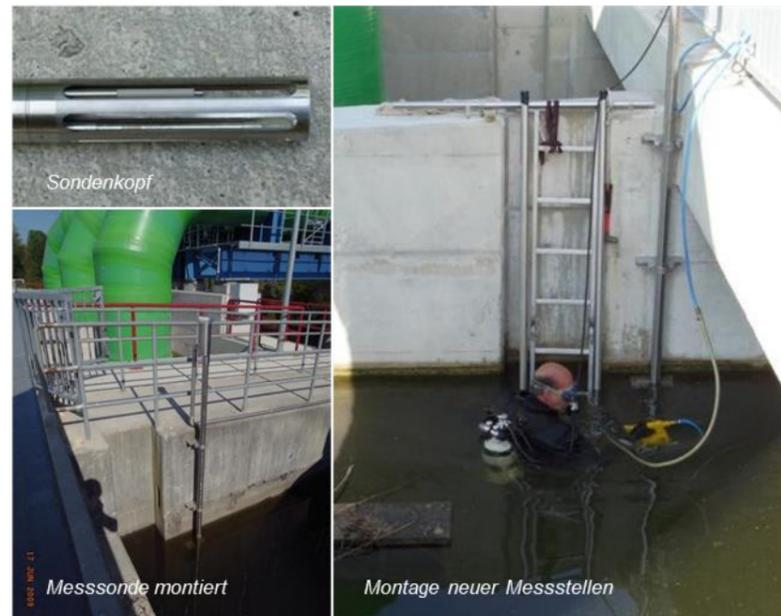
Für die Beobachtung von Wassertemperatur und Sauerstoffgehalt war es notwendig, ergänzend zu bestehenden Messstellen der Wasserwirtschaft zusätzliche Messstellen für die thermische Überwachung sowie Sauerstoffmessstellen einzurichten. Hierzu wurden an elf Stellen (Kraftwerk, Ufer, freie Donau,
